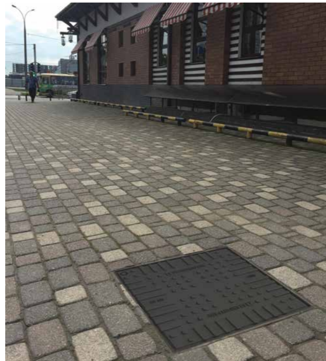
Установка люков на дождеприёмники Стандартпарк
