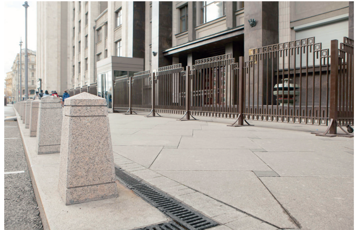
▲ Улица Моховая, г. Москва Линейный водоотвод. Серия Drive (Класс нагрузки D400)
