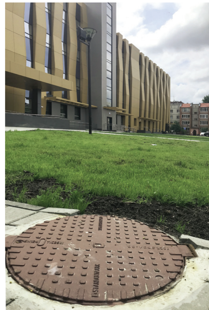
▲ Территория вокруг института физической культуры ТГУ, г. Тюмень Люк тип Т из высокопрочного чугуна с запорным устройством (Класс нагрузки С250)
