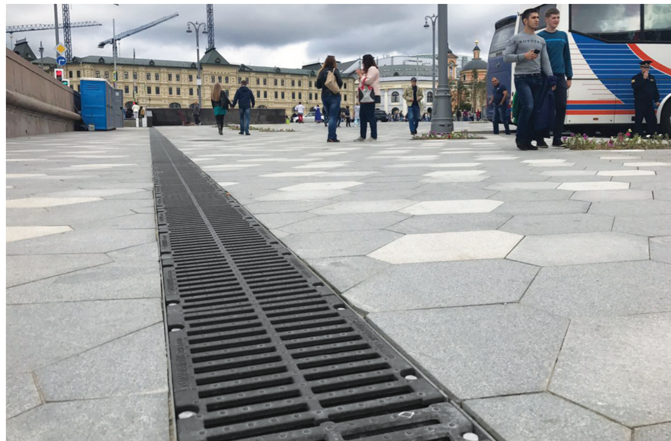
Парк Зарядье, г. Москва Линейный водоотвод. Серия Max (Класс нагрузки E600)
