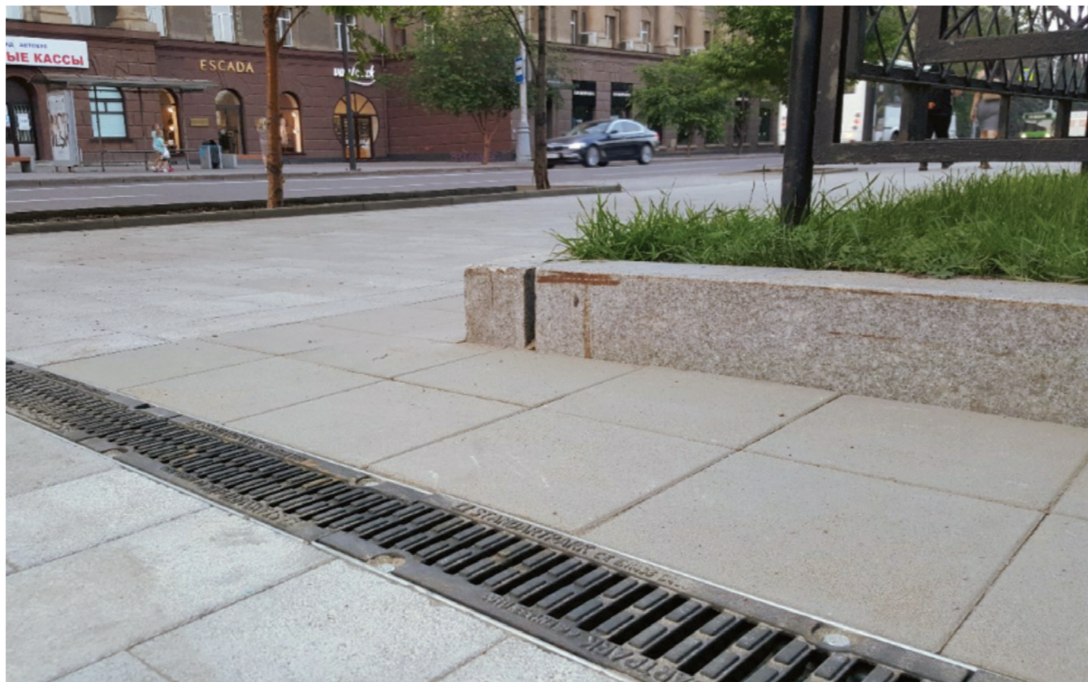
▼ Реконструкция проспекта Мира и ул. Дзержинского, г. Красноярск Линейный водоотвод. Серия Drive (Класс нагрузки D 400)
