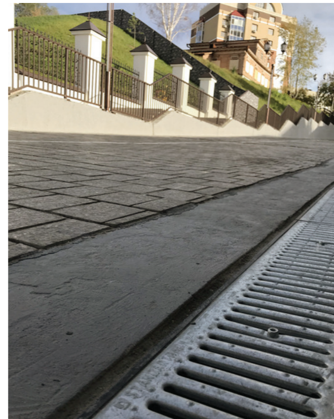
Масловский взвоз, г. Тюмень Линейный водоотвод. Серия Basic (Класс нагрузки A15)
