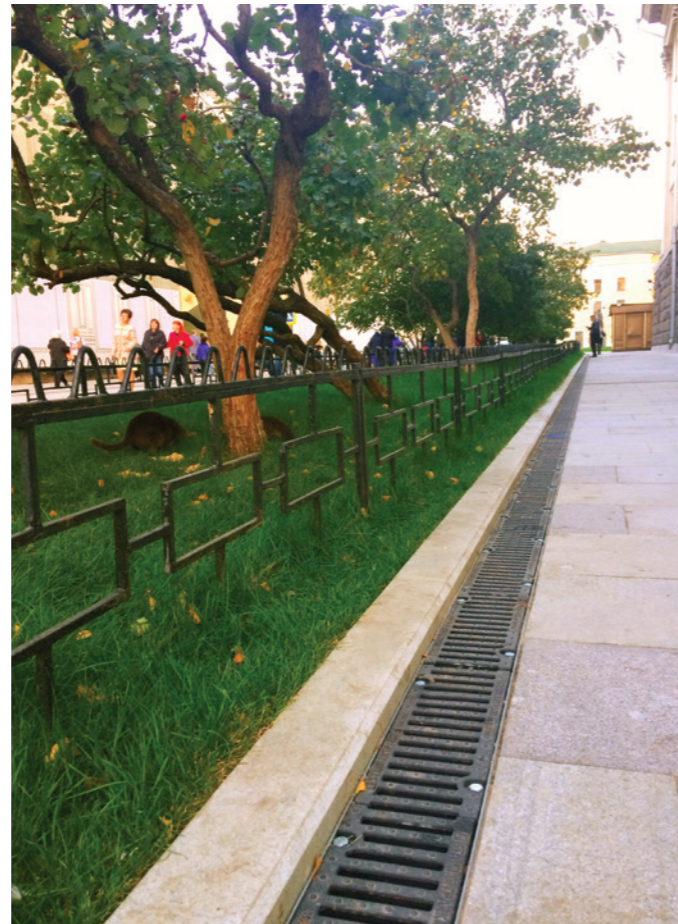
▲ Улица Рождественка, г. Москва Линейный водоотвод. Серия Drive (Класс нагрузки E600)
