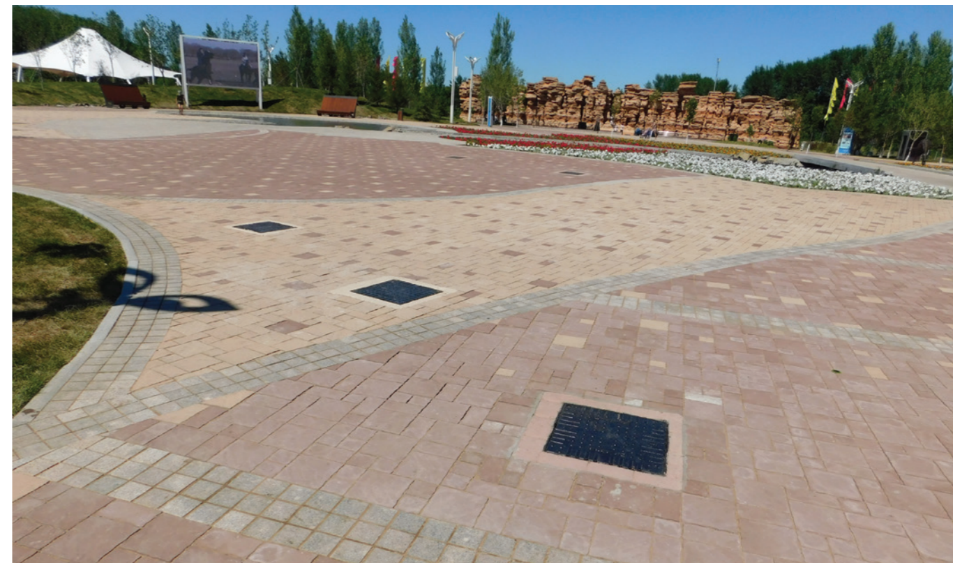
▲ Реконструкция Парка Арай Люк из высокопрочного чугуна квадратный (Класс нагрузки С250)
