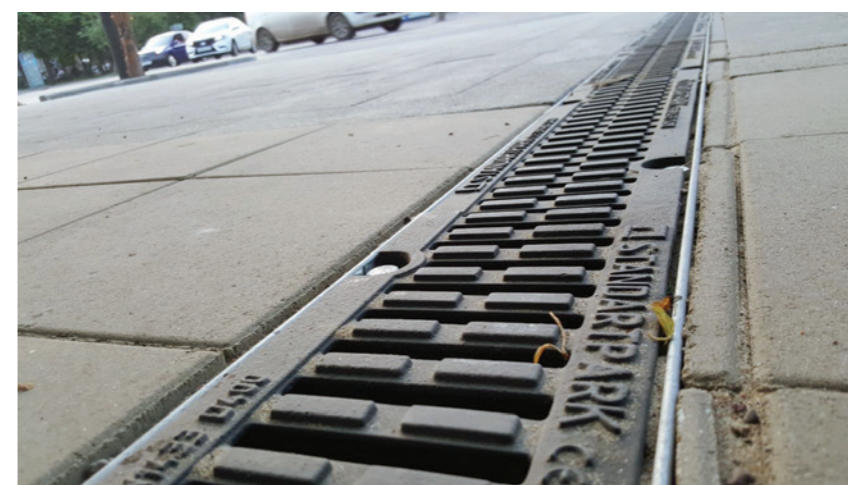
◀ Реконструкция проспекта Мира и ул. Дзержинского, г. Красноярск Линейный водоотвод. Серия Drive (Класс нагрузки D400)
