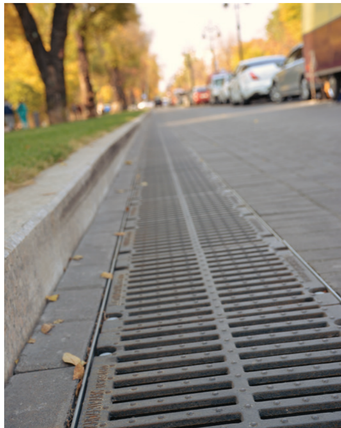
Улица Панфилова, Алматы Линейный водоотвод. Серия Max (Класс нагрузки E600)
