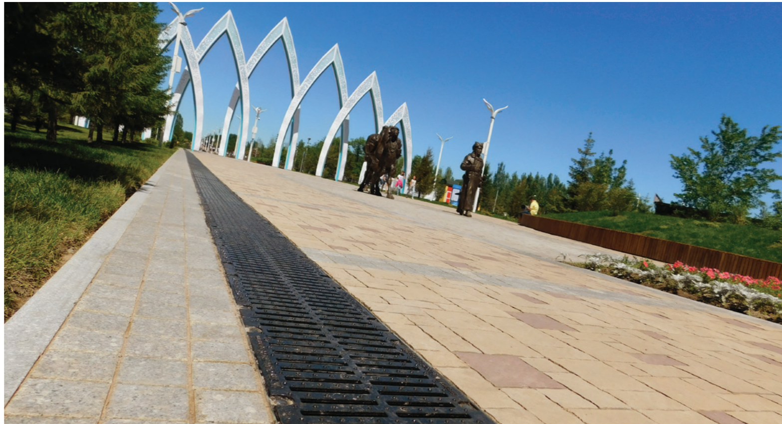
▲ Реконструкция Парка Арай, г. Нур-Султан Линейный водоотвод. Серия Max (Класс нагрузки E600)
