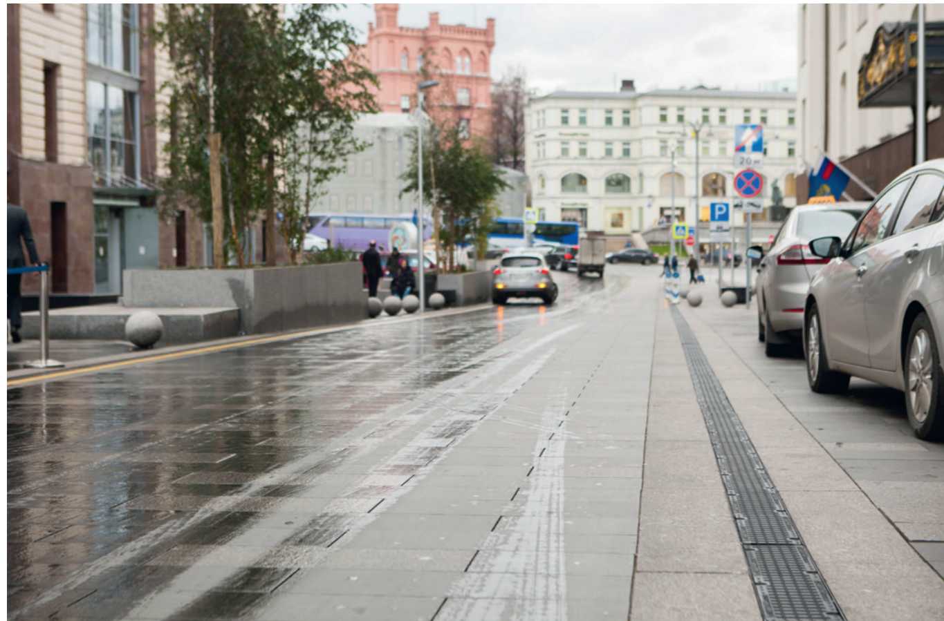
▲ Театральный проезд, г. Москва Линейный водоотвод. Серия Max (Класс нагрузки F900)
