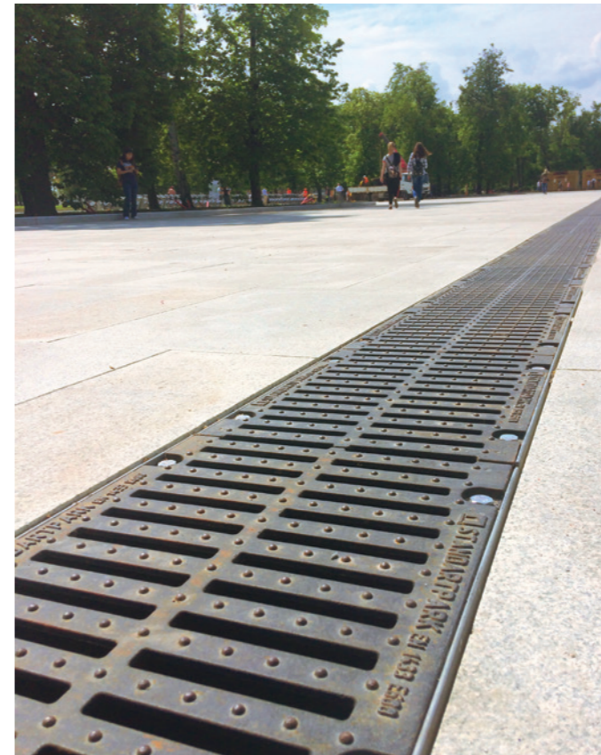
ВДНХ (главный вход), г. Москва Линейный водоотвод. Серия Drive (Класс нагрузки E600)
