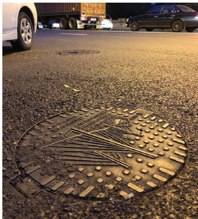
▲ Улица Светланская, г. Владивосток Люк тип Т из высокопрочного чугуна с запорным устройством (Класс нагрузки С250)
