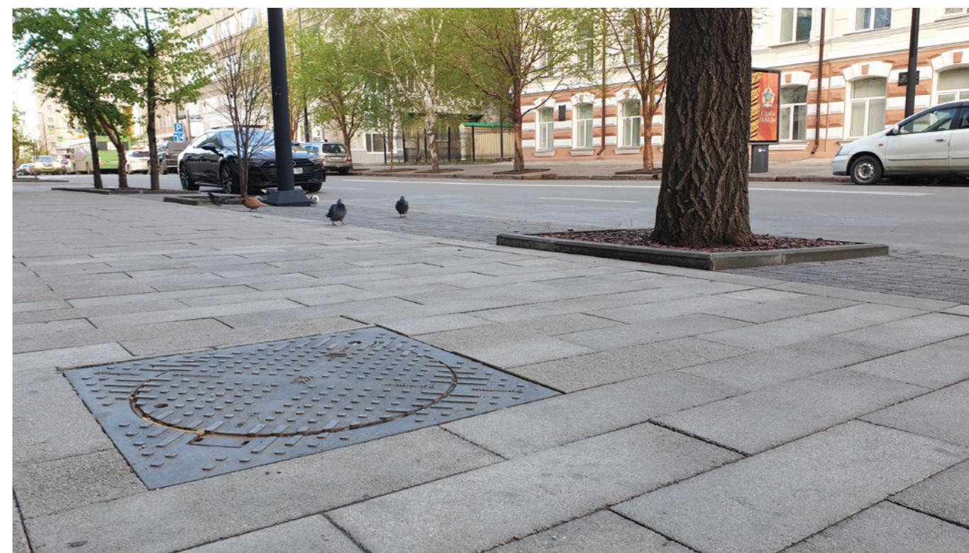
▲ Территория вокруг института физической культуры ТГУ, г. Тюмень Люк тип Т из высокопрочного чугуна с запорным устройством (Класс нагрузки С250)
