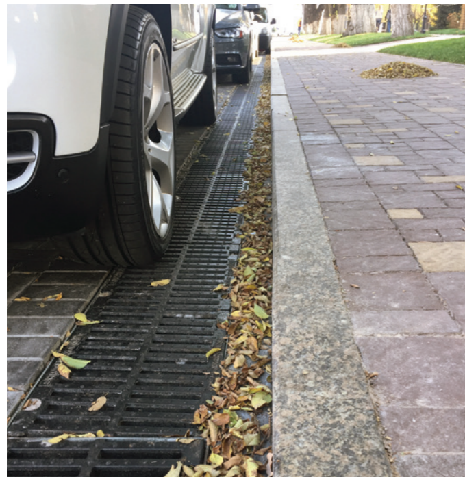
Улица Панфилова, Алматы Линейный водоотвод. Серия Max (Класс нагрузки E600)
