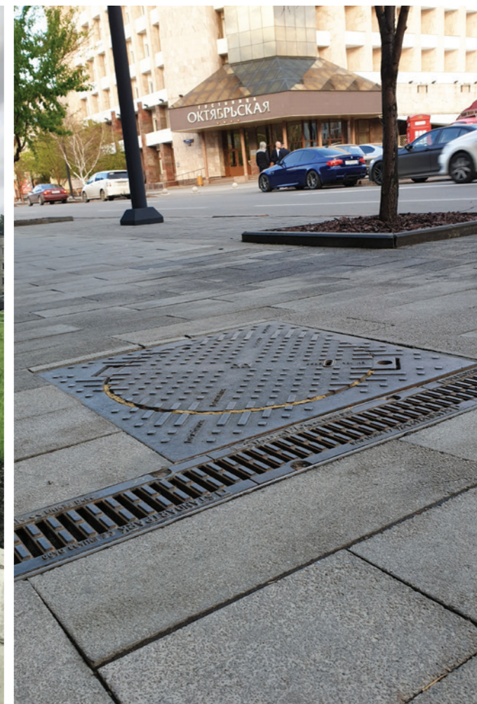
▲ Реконструкция проспекта Мира и ул. Дзержинского, г. Красноярск Люк тип Т из высокопрочного чугуна в квадратном корпусе с запорным устройством (Класс нагрузки С250)
