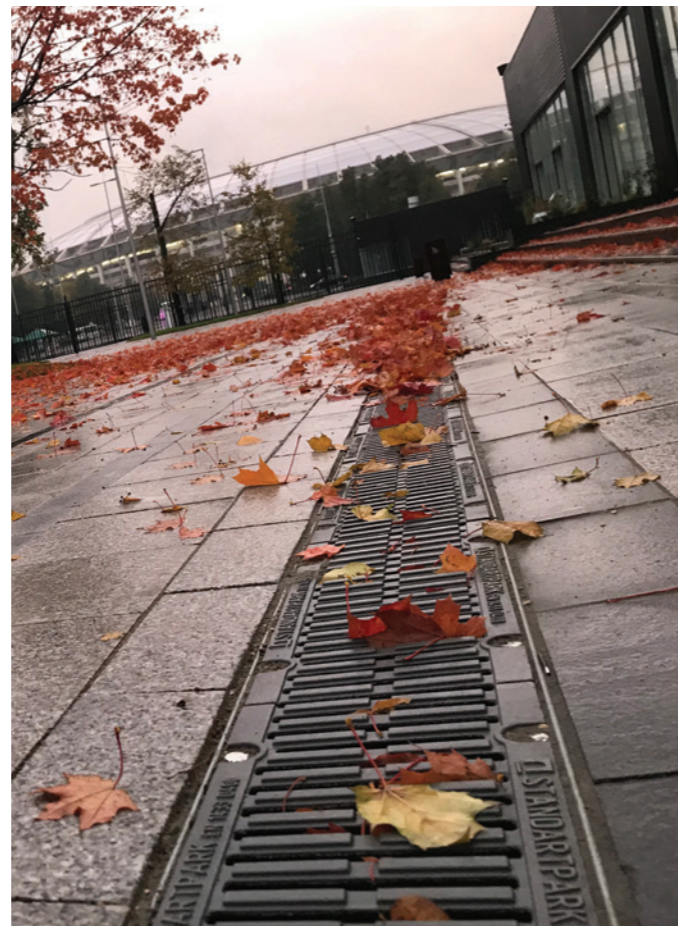
Спортивный комплекс Лужники, г. Москва Линейный водоотвод. Серия Drive (Класс нагрузки D400)
