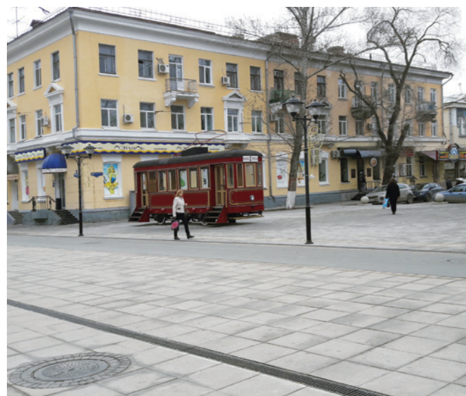
▼ Реконструкция ул Волжская, г. Самара Линейный водоотвод. Серия Drive (Класс нагрузки D400)
