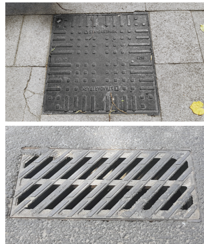
▲ Улица Карла Маркса, г. Воронеж Дождеприемник магистральный тяжелый чугунный с запорным устройством тип ДМ (Класс нагрузки С250)
