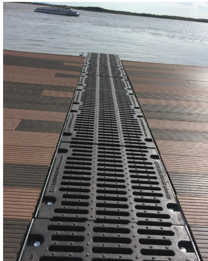
Реконструкция Центральной набережной г. Хабаровска Линейный водоотвод. Серия Max (Класс нагрузки E600)
