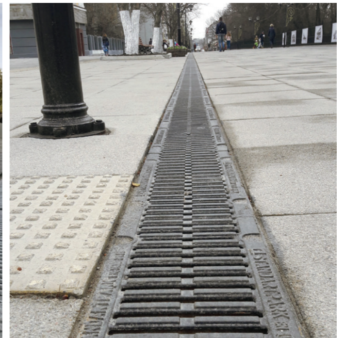
Масловский взвоз, г. Тюмень Линейный водоотвод. Серия Basic (Класс нагрузки A15)
