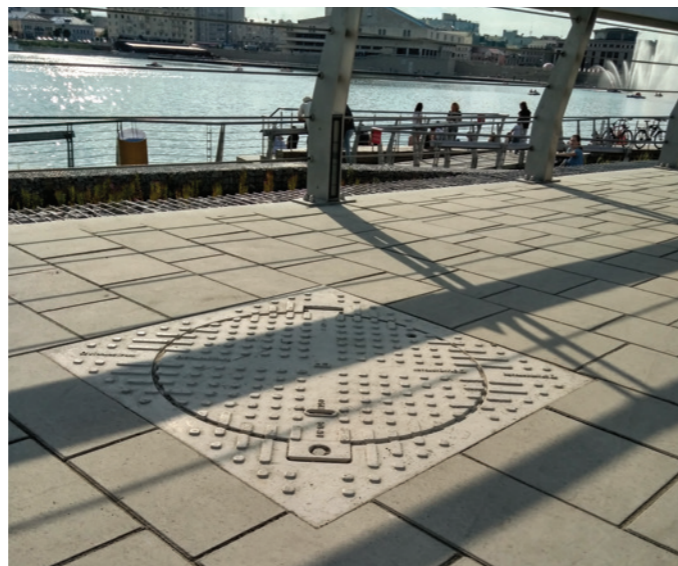
▲ Благоустройство набережной оз. Нижний Кабан, г. Казань Люк тип Т из высокопрочного чугуна в квадратном корпусе с запорным устройством (Класс нагрузки С250)
