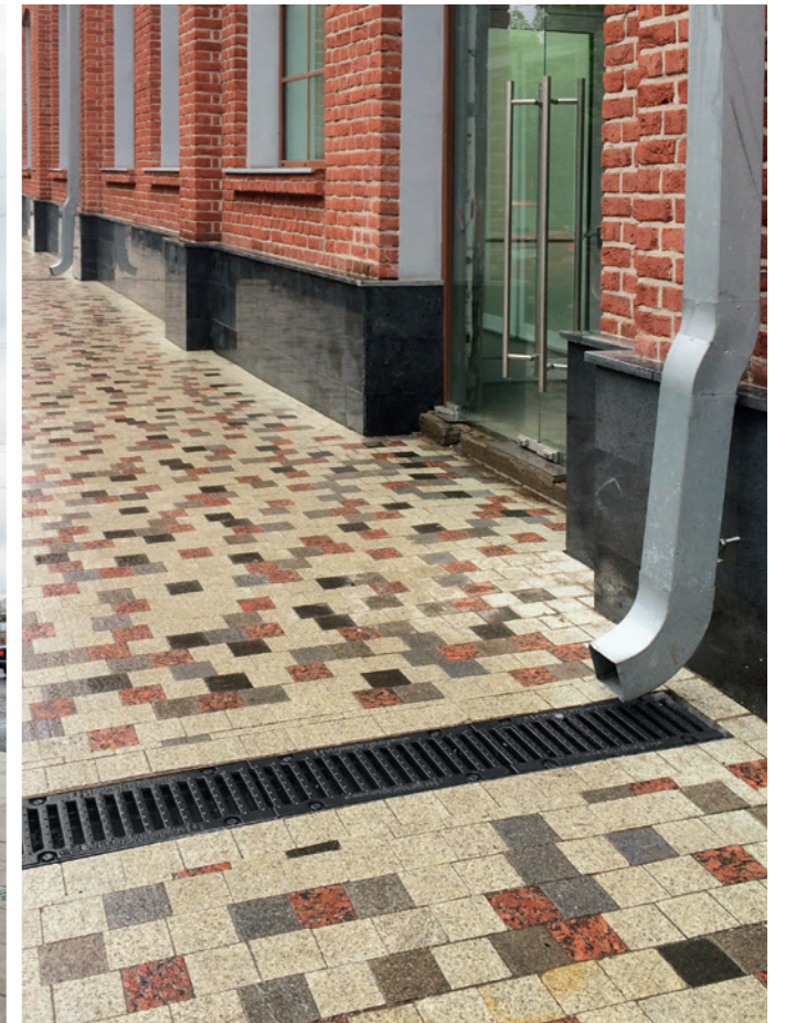
Большая Якиманка, г. Москва Линейный водоотвод. Серия Drive (Класс нагрузки D400)
