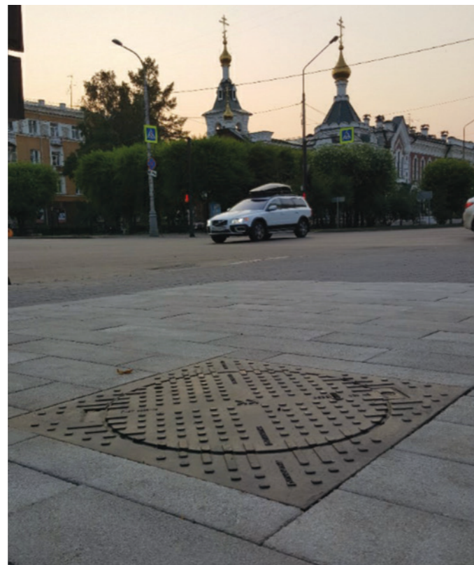
▲ Реконструкция проспекта Мира и ул. Дзержинского, г. Красноярск Люк тип Т из высокопрочного чугуна в квадратном корпусе с запорным устройством (Класс нагрузки С250)
