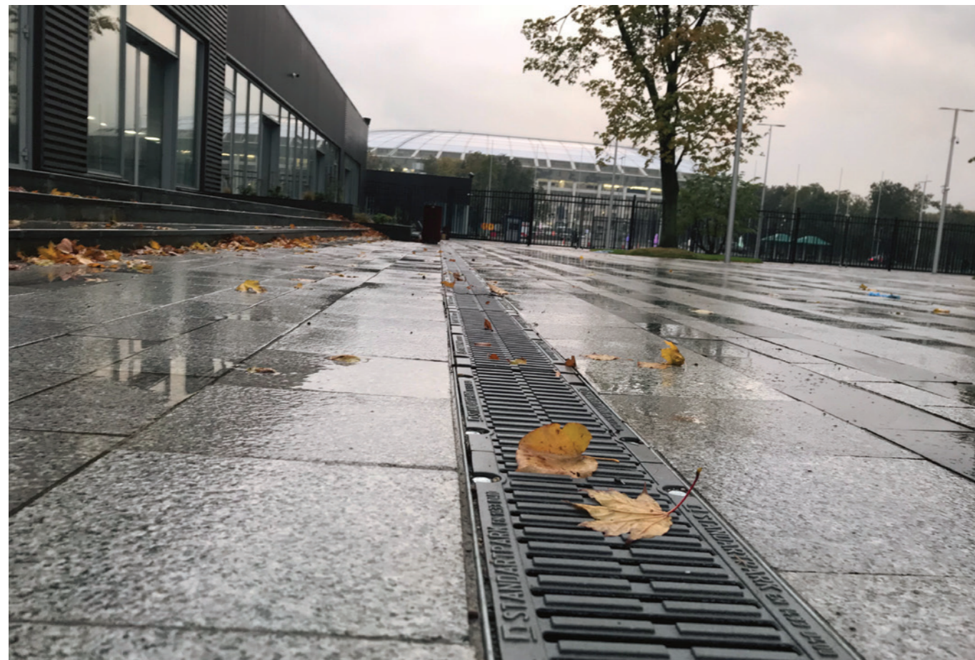
Спортивный комплекс Лужники, г. Москва Линейный водоотвод. Серия Drive (Класс нагрузки D400)
